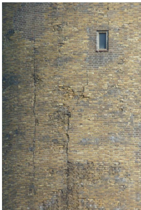
Afbeelding 5: Transversaalscheuren
