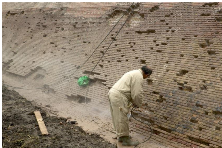
Afbeelding 1. Zeer plaatselijk uithemen van individuele baksteen
