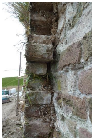
Afbeelding 3: Lateraalscheur
